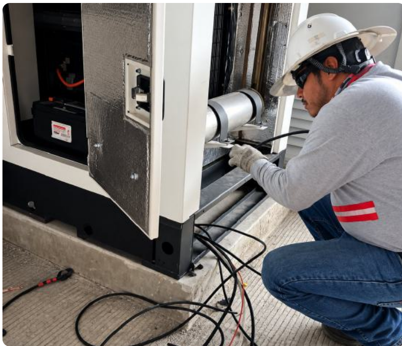
Instalación de planta de emergencia.
