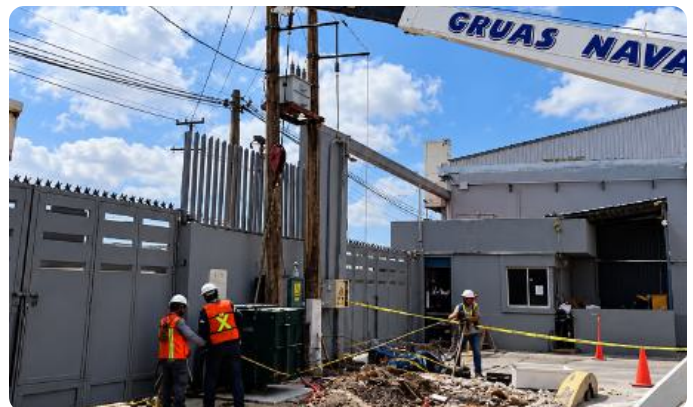
Montaje de transformador eléctrico
