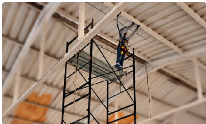
Modernización de instalación eléctrica
