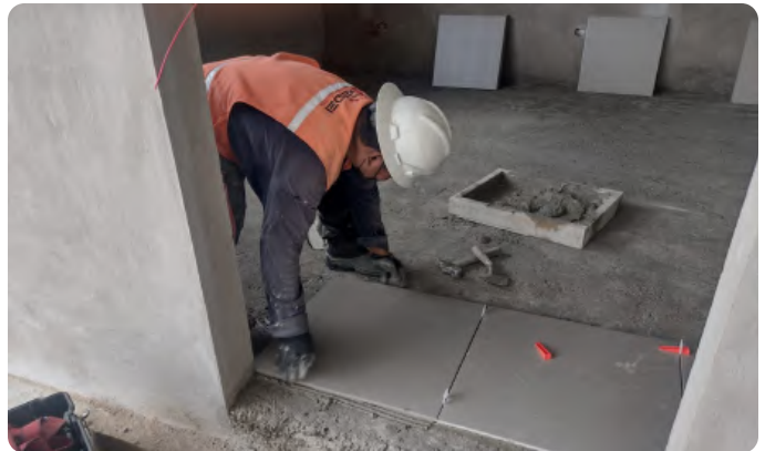
Colocación de pisos cerámicos.
