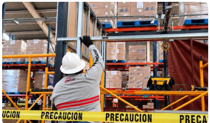
Construcción de oficinas con panel Tablaroca.
