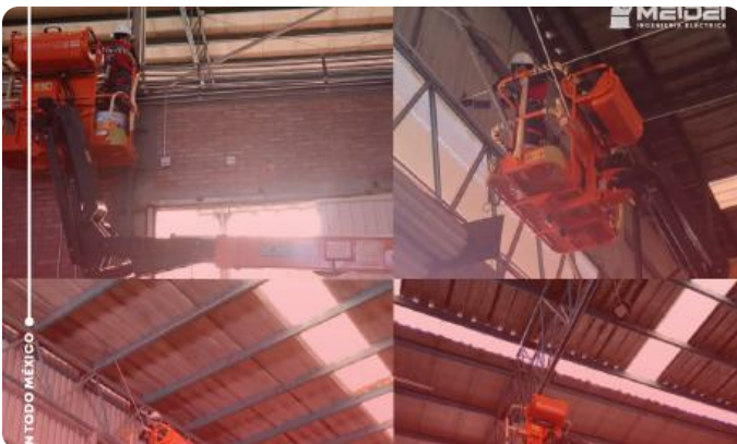
Instalaciones eléctricas, adecuaciones, remodelaciones.
