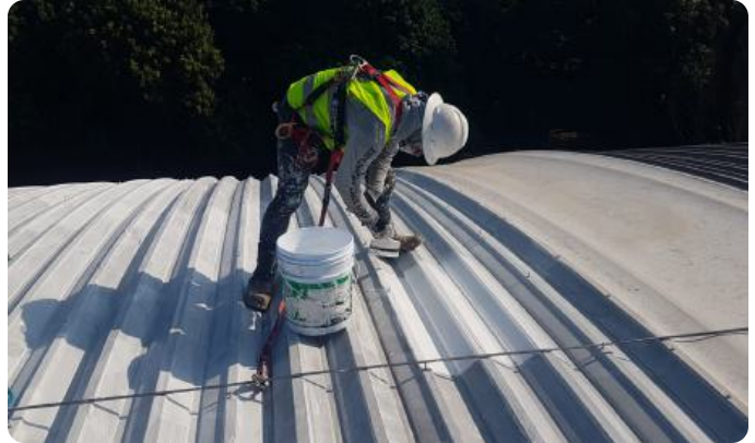
Impermeabilización de cubiertas en naves industriales.
