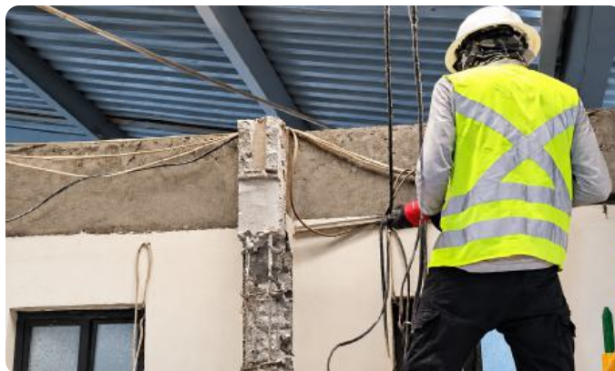
Demoliciones, remodelaciones, adecuaciones de obra civil.
