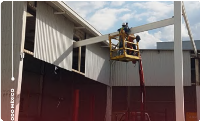
Montajes y ampliación de naves.
