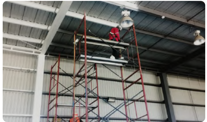
Pintura en estructuras metálicas
