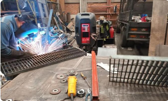
Fabricación de herrerías
