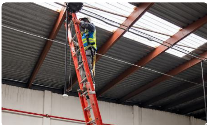
Modernización alumbrado en almacenes.
