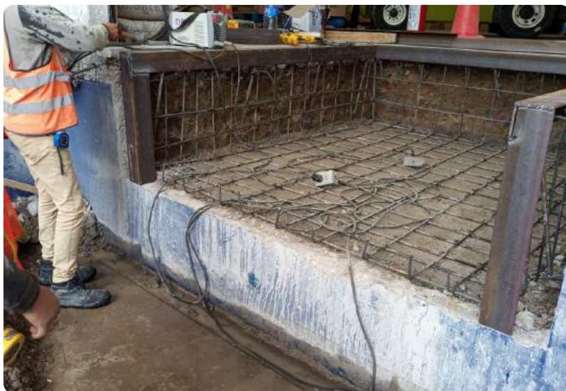
Fabricación de fosa para rampa de andén.
