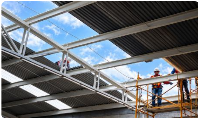
Montaje de estructura metálica y cubierta en nave industrial.
